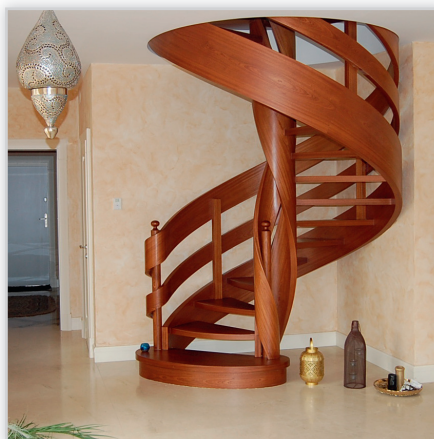
Schody Jaworski. Konstrukcja: policzkowa ażurowa. Balustrada: dwie wstęgi. Drewno: sapeli.
