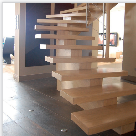
Schody Jaworski. Konstrukcja: schody zabiegowe na jednej belce. Balustrada: stal szlachetna, poręcz drewniana. Drewno: dąb bielony.
